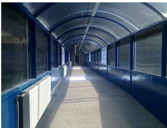
Interiér spojovacej chodby
